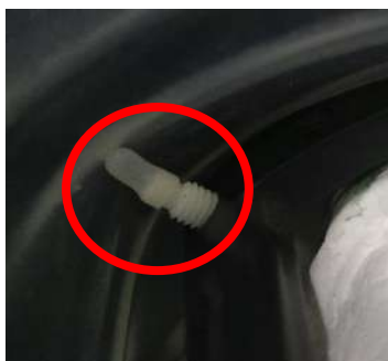
Figur 1-22: Membranskyddande silikonlock på skruvens ände
