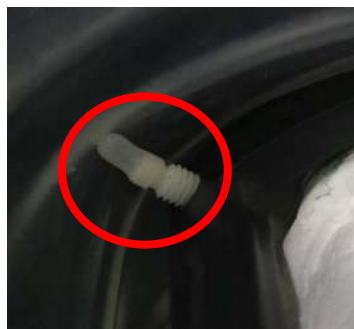
Figure 1-22 : Capuchons en silicone de protection de la membrane à l'extrémité des vis
