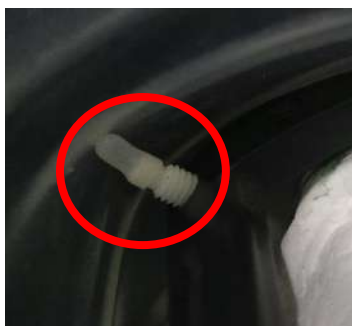
Figur 1-22: Membranbeskyttende silikonehætter på skruens yderste del
