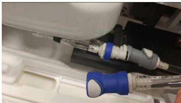
Figur C - 1: Afbrydelse af vandinstallation
